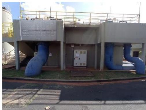
**Figura 6.4 – Adutoras com saída da mistura rápida para as ETAs**
