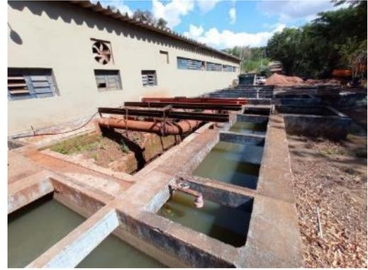
**Figura 4.44 – Canal de distribuição e Tanques de sucção da estação elevatória de água bruta**
