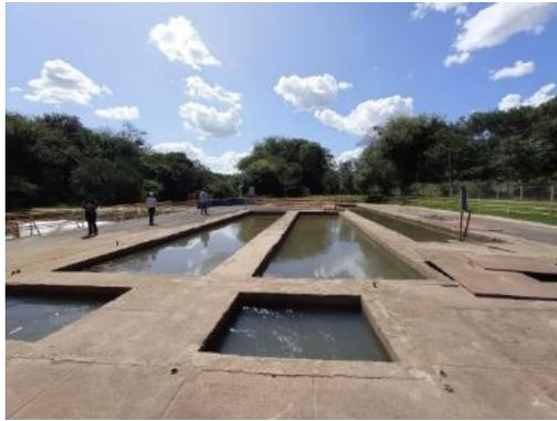
**Figura 4.43 - Caixas de areia da estação de captação de Uberaba**
