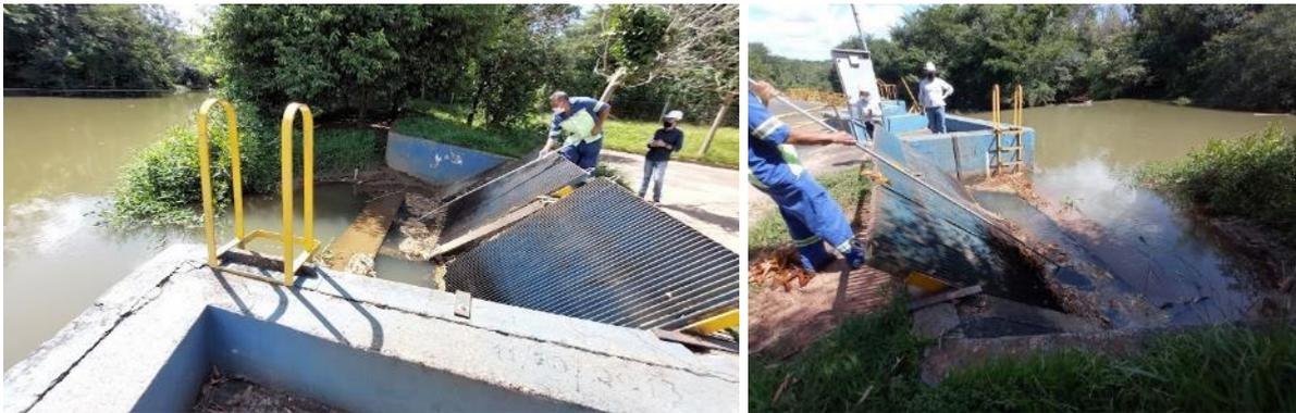
**Figura 4.41 – Limpeza da grade da estação de captação sendo realizada**
