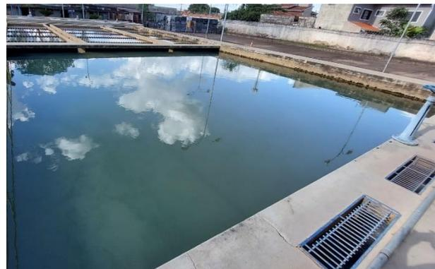
Figura 6.8 – Decantador convencional - ETA 1
