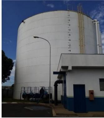
**Figura 7.27 – Reservatório metálico apoiado do CR5**
