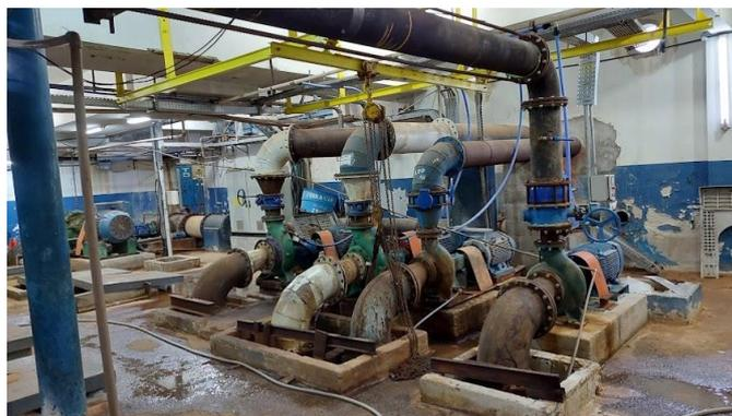
**Figura 6.20 – Elevatórias de água tratada**
