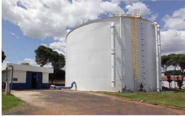
**Figura 7.56 – Reservatório metálico apoiado do CR 11**
