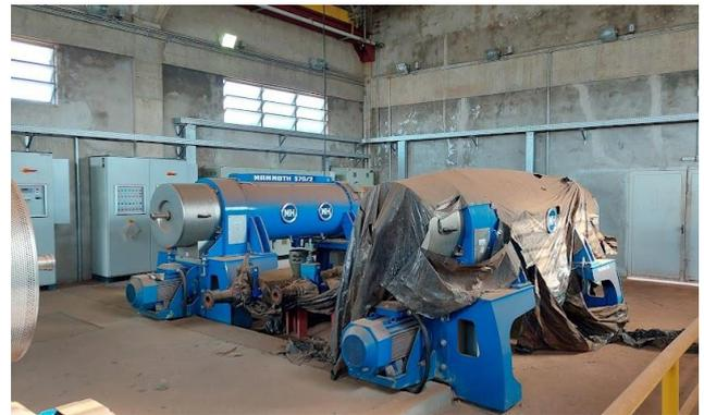
**Figura 6.25 – Unidade de adensamento e desaguamento de lodo da ETA**
