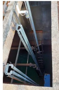
**Figura 6.24 – Tanques de equalização e alimentação dos adensadores mecanizados**
