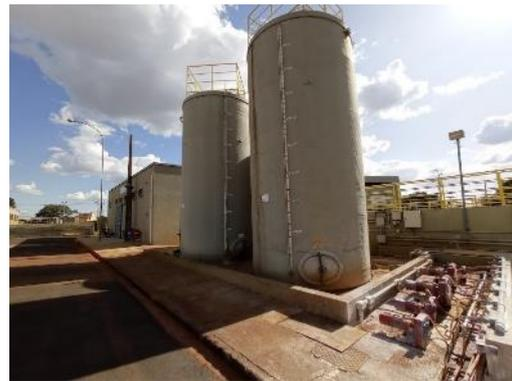
**Figura 6.3 - Aplicação de produtos químicos (tanque de mistura rápida), bombas e armazenamento**
