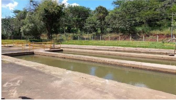
**Figura 4.42 – Caixas de areia da estação de captação de Uberaba**
