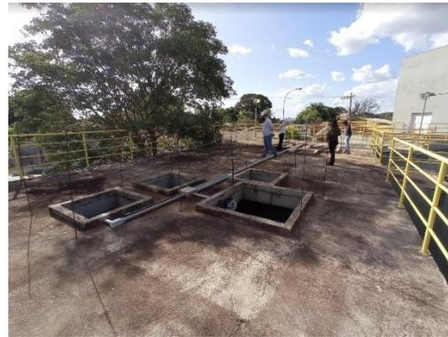
**Figura 6.23 – Tanques de recepção de lodo e recirculação de lodo**
