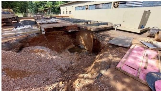
**Figura 4.47 – Obra dos poços de sucção**
